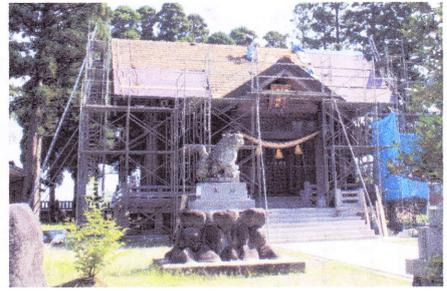
老朽化が進みかねてから修復の望まれていた延喜式内林神社拝殿の全面葺き替え工事がいよいよ着工されることとなり、七月七日に齋行された除蝗祭に併せて工事の安全が祈願され、九日から瓦の撤去作業に入りました。工費は当初予算額で約三百八十万円余りが見込まれています。工事は例大祭前には完工する予定です
